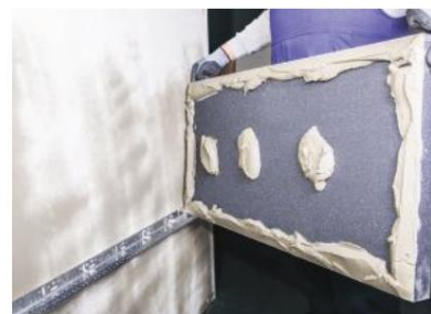
Figure 3 Lors de l'application du mortier-colle au dos du panneau d'isolation thermique, il convient de veiller à ce qu'il ne déborde pas sur les bords.
