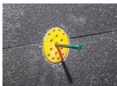
Figure 3 : Les chevilles sont placées dans le trou de cheville ouvert et les clous de cheville sont complètement enfoncés.
