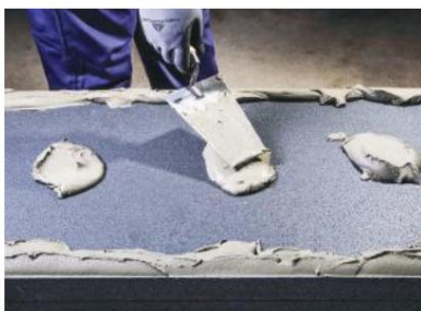
Figure 2 En cas de différences de niveau ou de courbures sur la surface, la « méthode d'application par bandes et par points » est appliquée et le mortier-colle est appliqué au dos du panneau d'isolation thermique en bandes continues le long de tous les bords et en points dans les sections médianes, avec une truelle.
