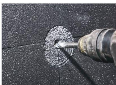
Figure 2 L'emplacement de la cheville est percé avec une perceuse. La longueur du trou doit être 1 cm plus grande que la longueur du goujon.
