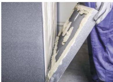
Figure 1 Le panneau d'isolation thermique, avec le mortier-colle appliqué au dos, doit être placé sur le profilé de fondation sans aucun espace.
