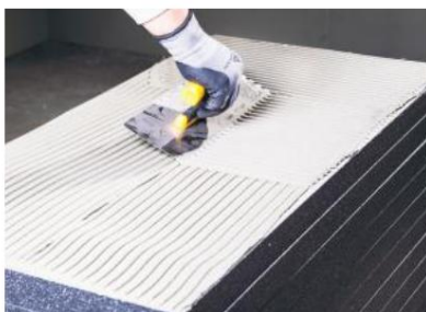
Figure 1 Si la surface est lisse, la « Méthode d'adhésion sur toute la surface » est appliquée et le mortier-colle est appliqué sur l'ensemble du panneau d'isolation thermique à l'aide d'une truelle ou d'une truelle crantée appropriée.
