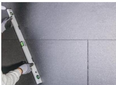
Figure 2 Les panneaux isolants sont collés au mur en les décalant légèrement pour qu'ils soient entièrement en contact avec le mur. La vérification des niveaux des plaques doit être effectuée avec une jauge ou un niveau à bulle.
