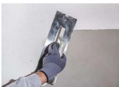
Figure 1 Le plâtre décoratif texturé minéral bleu d'Istanbul est appliqué sur la surface à l'aide d'une truelle.
