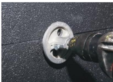
Figure 1 La tête de la cheville, qui doit être sélectionnée en fonction de la caractéristique du mur, doit être placée exactement et la tête fraisée doit être ouverte à l'aide de l'appareil pour éviter qu'elle ne forme une épaisseur.
