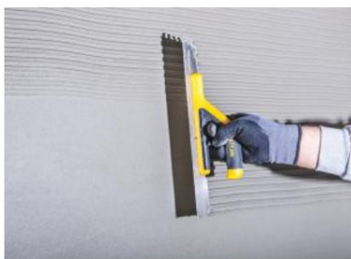
Figure 1 Après le collage et le chevillage des panneaux d'isolation thermique Istanbul Blue, la première couche d'enduit de surface est appliquée. Le mortier de plâtre Istanbul Blue préparé est appliqué de manière homogène sur la surface en quantités égales à l'aide d'une truelle en acier. L'épaisseur d'application de l'enduit de surface doit être au maximum de 2 mm pour chaque couche.
