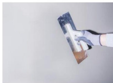
Figure 3 En fonction des conditions météorologiques, l'application de la deuxième couche de mortier de plâtre est complétée en attendant que la première couche de mortier de plâtre s'égoutte légèrement.
