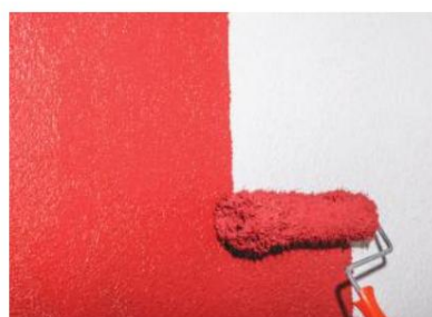
Figure 3 Enfin, l'apprêt extérieur et la peinture sont appliqués.
