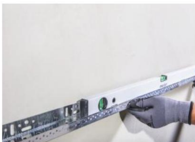
Figure 1 L'installation du profil de substrat bleu Istanbul garantit que le système de revêtement est équilibré et lisse. Afin de corriger d'éventuelles courbures de la surface, les espaces, les creux et les saillies entre le mur et le profilé du sous-sol sont corrigés avec des cales de différentes épaisseurs et la surface est équilibrée.
